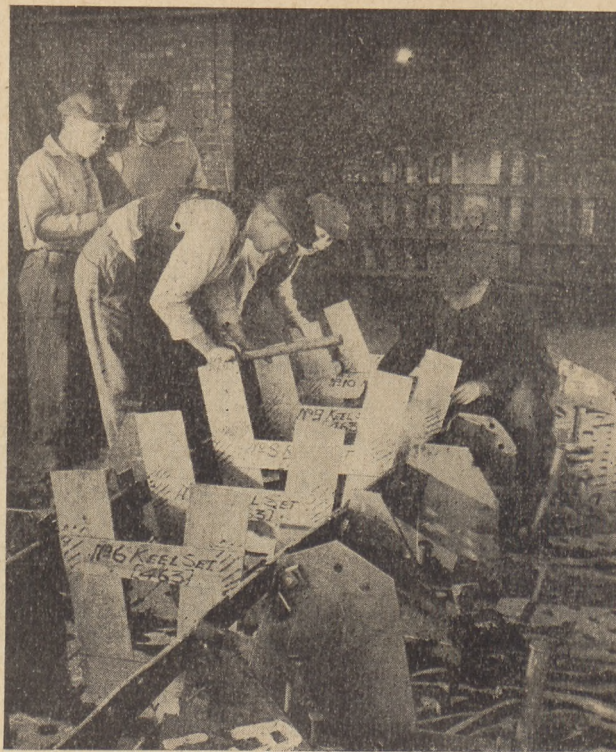
b) Prowizoryczne łóże do krępowania płytki stępkowej
