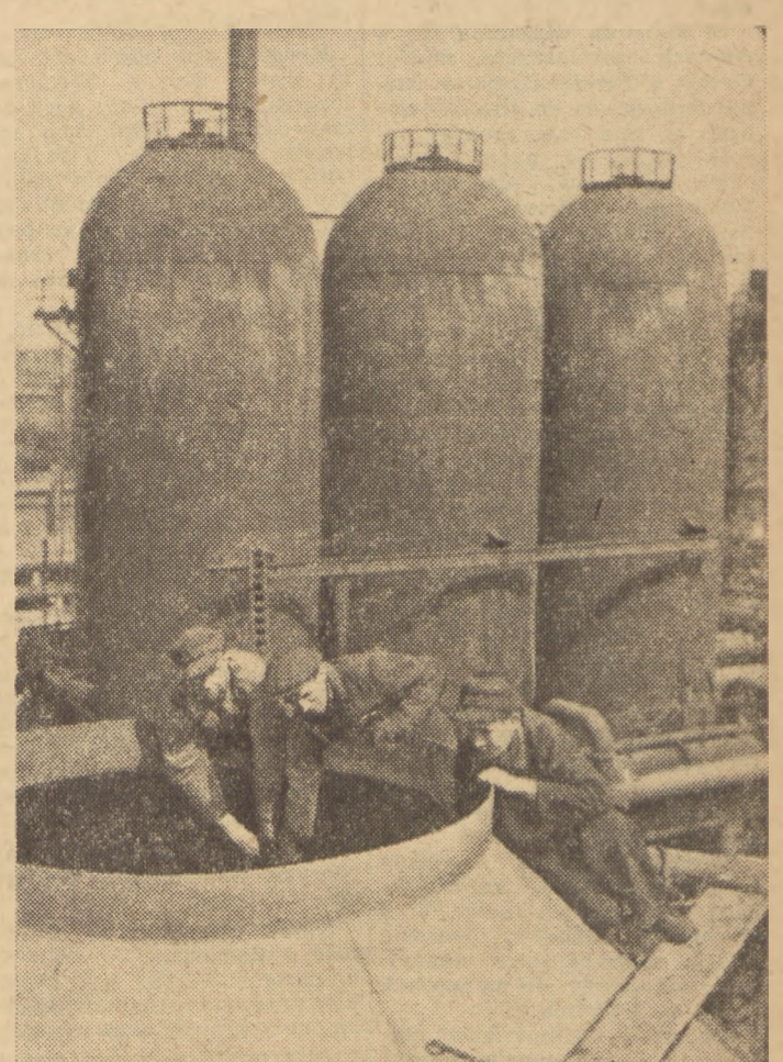
Po uruchomieniu w roku ubiegłym pieca „B” przystąpiono do dalszej rozbudowy huty „Kościuszko”. Jeszcze trwają prace nad budową nowoczesnej, zmechanizowanej koksowni — a już rozpoczęły się roboty przy wznoszeniu wielkiego pieca „C”, który jeszcze w tym roku rozpocznie utapianie surowca. Na zdjęciu: brzołka Gerarda Fortuny przy montażu płuczek pieca „C”. Foto CAF — Kondracki
