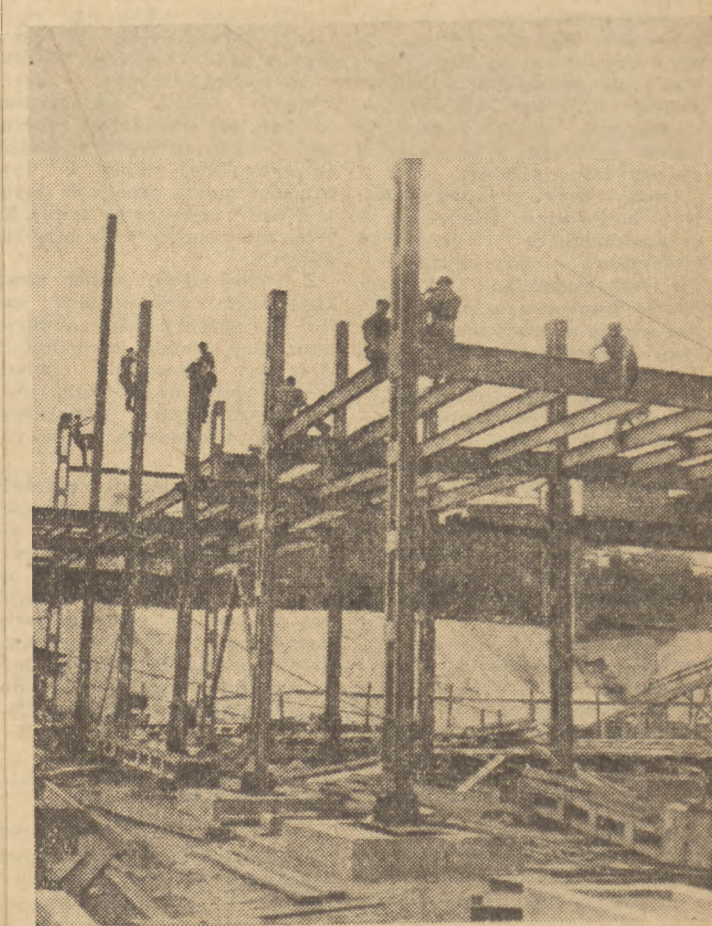
Na Śląsku powstaje jedna z największych kopalni węgla w Polsce — kopalnia „Gigant”. Na zdjęciu: brigada monterska Wiktora Kieronima, pracująca przy budowie kopalni, montująca stalową konstrukcję sortowni. Foto CAP
