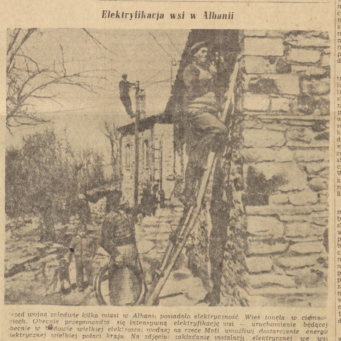
Elektryfikacja wsi w Albanii. Obecnie przeprowadza się intensywną elektryfikację wsi - uruchomienie będącej obecnie w budowie wielkiej elektrowni wodnej na rzece Mati umożliwi dostarczenie energii elektrycznej wielkiej potęgi kraju. Na zdjęciu: zakładanie instalacji elektrycznej we wsi Robochitisa w Kercicha
