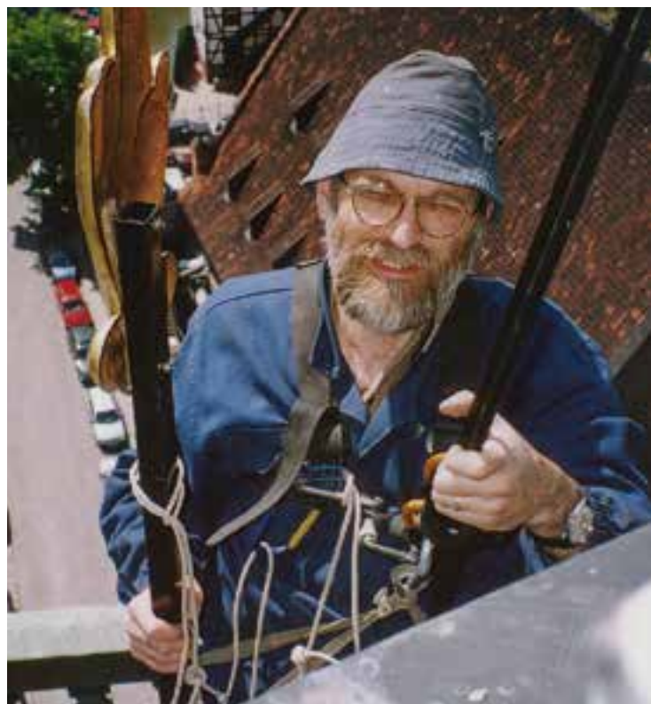
Grzegorz Szychliński, wieża kościoła św. Katarzyny. ► Montaż wskazówki zegara wieżowego
