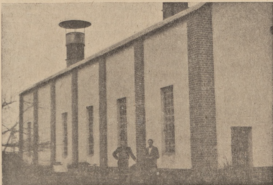
Fot. A. Suszarnia typu łębnowego (widok zabudowania)
