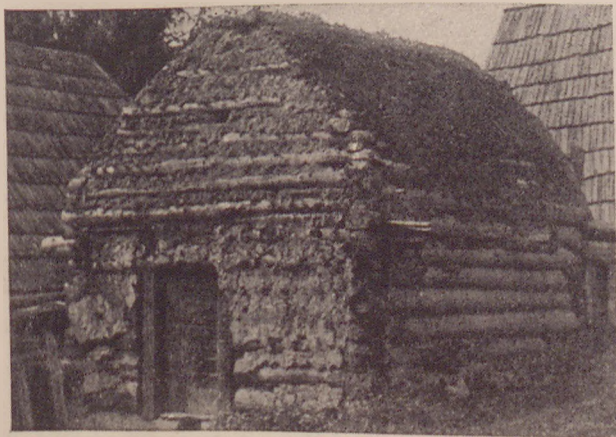
Ryc. 29. Sypaniec po zdjęciu dachu. Kocwin, pow. Nowy Targ. Fot. R. Reinfuss 1938 r.
