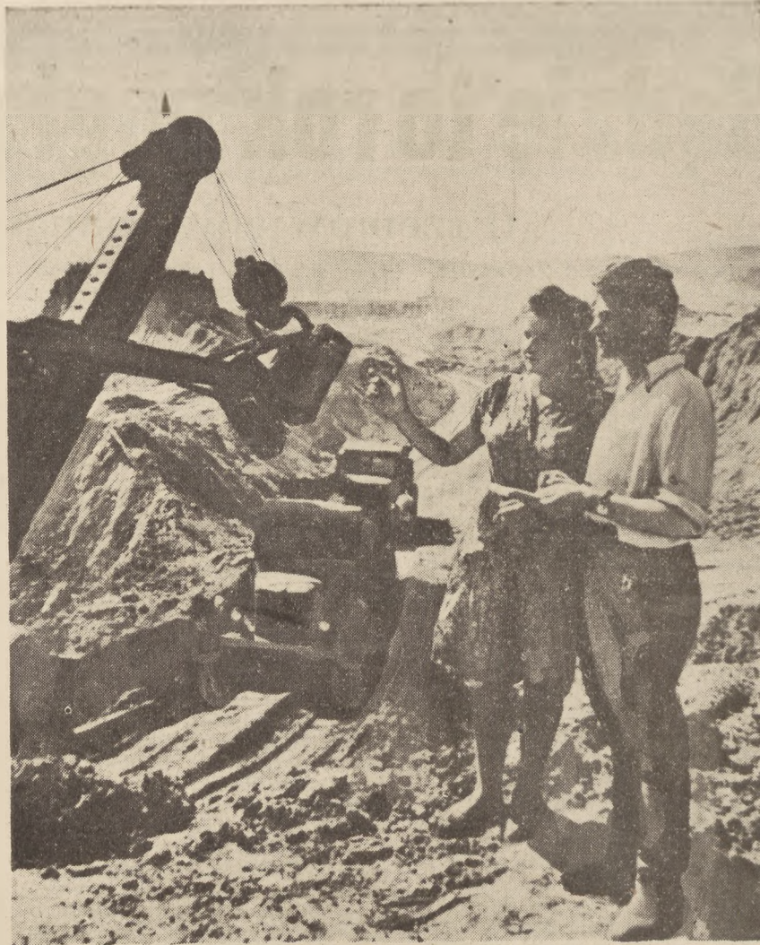
Budowa elektrowni wodnej w Kujbyszewie. Technik L. Ulianinskaży zdej kierownikowi wykopów inż. G. Paszkiewiczowi sprawozdanie ze stanu prac na swojej zmianie.
