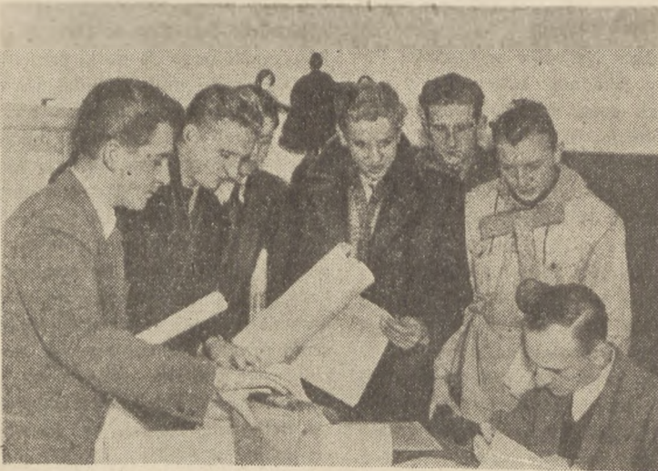
Na 4 dni przed terminem zobowiązanie zostało wykonane. Na zdjęciu: ostatnie zespoły oddają wykonane prace. Od lewej kol. kol. Kostrowicki, Szczepański, Chojnacki, Miecznikowski, Dębno, Lubczyński, foto A. Jastrzębski.
