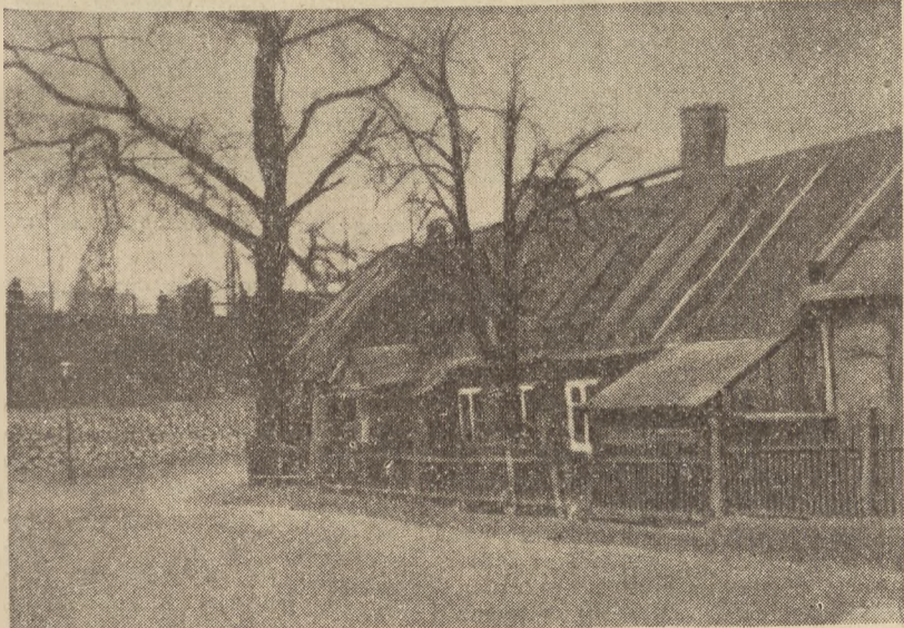
W robotniczych dzielnicach Woli, Ochoty, Powiśla i Pragi, w zatłoczonych izbach starych wilgotnych ruder gnieździły się tysiące rodzin warszawskich robotników. W takim oto, jak ten budynek, mieszkał m. in. Mietek Gajda
