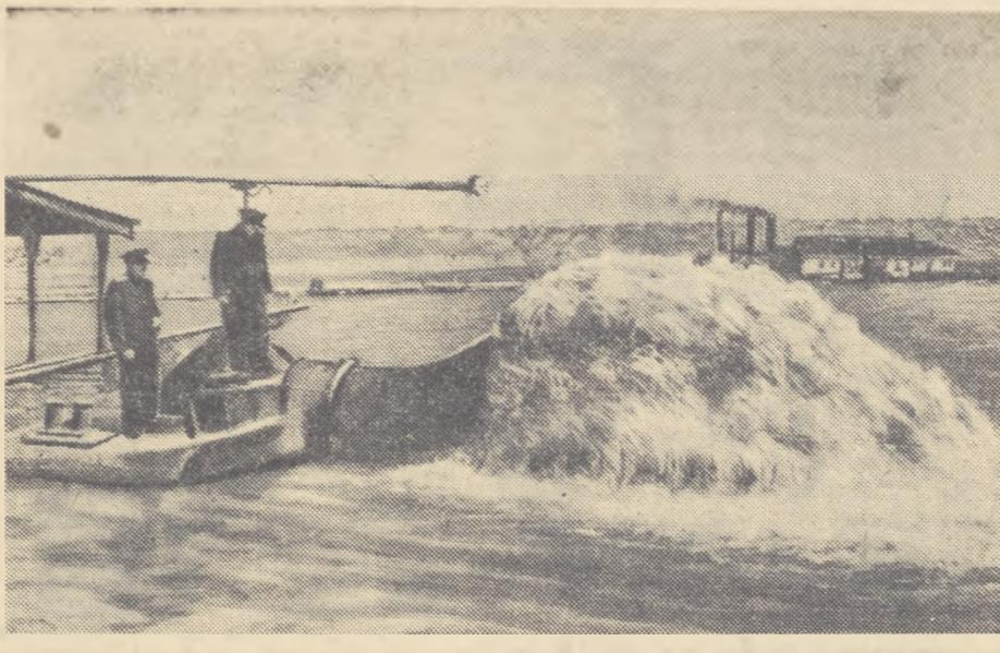
Куйбышевский технический участок Волжского бассейнового управления пути ведет работу по углублению дна реки на мелководных перекатах Средней Волги. На снимке: землесос «Волжский-7» за выброской грунта со дна реки. За час работы он выбрасывает сотни кубометров грунта.
