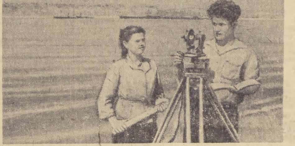
Сталинград. На месте предстоящей стройки развернулись изыскательские работы. На снимке: младший техник-теплогрф А. Ф. Варков и рабочий Т. Ф. Воробьева за разбивкой разведочных скважин на месте, где будет сооружаться плотина.
