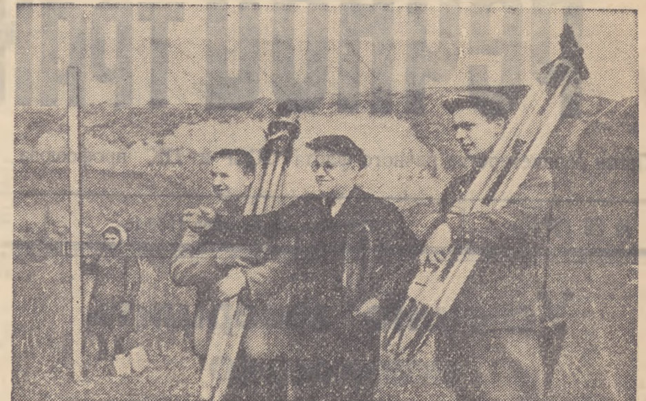
На трассе Южно-Украинского канала развернулись изыскательские работы. На снимке (слева направо): инженер-гидротехник Я. К. Пономаренко, старший инженер-экономист И. А. Сидоренко и инженер-гидротехник А. М. Штыко на месте работ.
