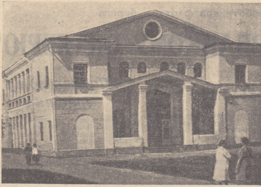
Скоро в этом просторном доме-дворце под Москвой зазвенит голоса детей работников Уральского речного флота. В здании идут последние отделочные работы. На снимке: общий вид двухэтажного детского дома на Клязьме, построенного по проекту архитектора А. Курносова. Фото И. ЛУДМАНА.
