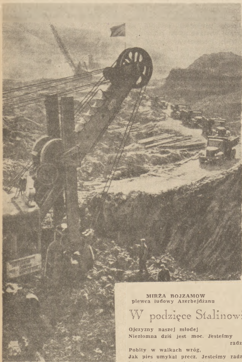
Ekskawatorki przy wykopie pod fundamenty hydroelektrowni
