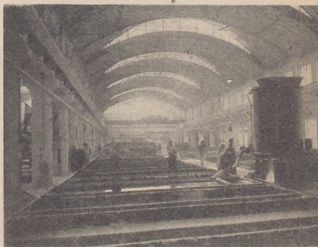
NOWY ZAKŁAD PRZEMYSŁOWY — NA WIĘKSZA W KRAJU FABRYKA GAZOBETONU
