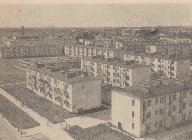
OGÓLNY WIDOK NOWOWZNIESIONEGO OSIEDLA NA MOKOTOWIE
