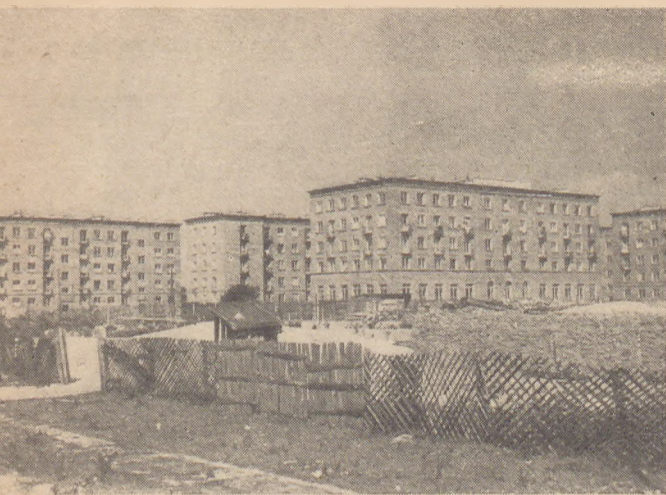
BUDOWA NOWEGO OSIEDLA MIESZKANIO- WEGO NA OCHOCIE
