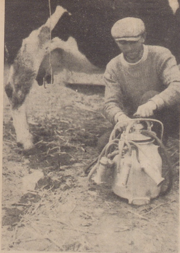
Ogólny widok aparatu udojowego „WIM”. Kubki udojowe po założeniu na strzyki zostaną zawieszono na sznurku przerzuconym przez grzbiet krowy
