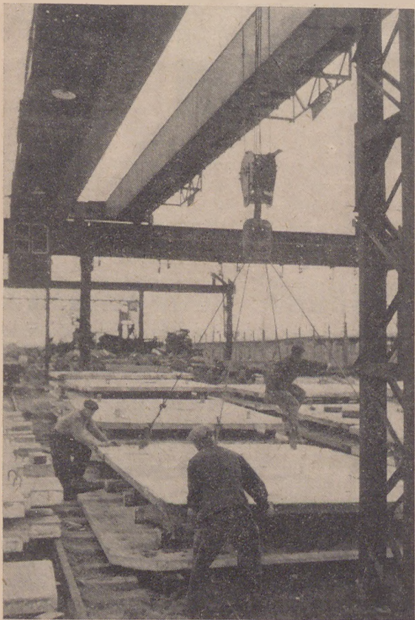
Suwnica ramowa przenosiła płyty na podręczny skład
