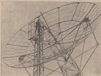
Antena radioteleskopu na forcie „Skala”. Średnica 5 m, siatka z drutu miedzianego. Odbiór fal długości 1 m
