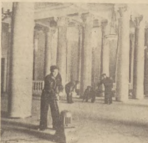
W foyer klubu studenckiego dobiegają końca ostatnie prace.
