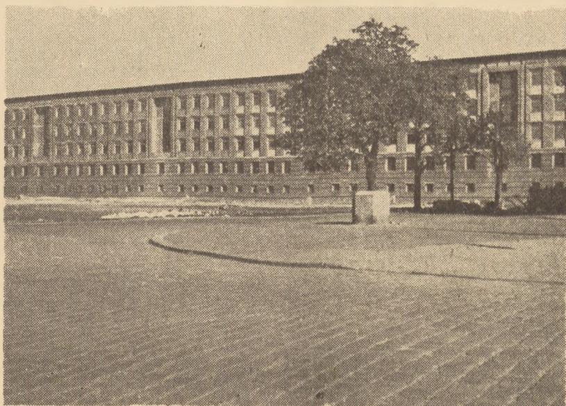
Na dawnym targowisku w niespełna rok stanął pierwszy segment gmachu wydziału górniczego. Zakończenie budowy kompleksu gmachów dla tego wydziału przewidziane jest na rok 1960. (Foto S. Polony)
