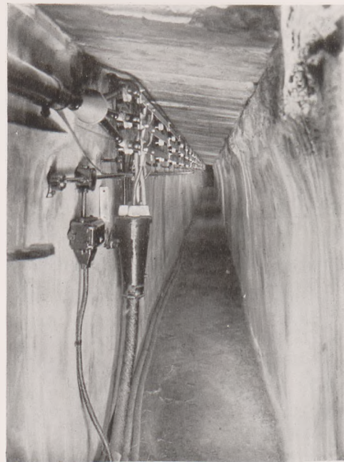
Abb. 2. Begehbare Kanal in der Kaimauer.
