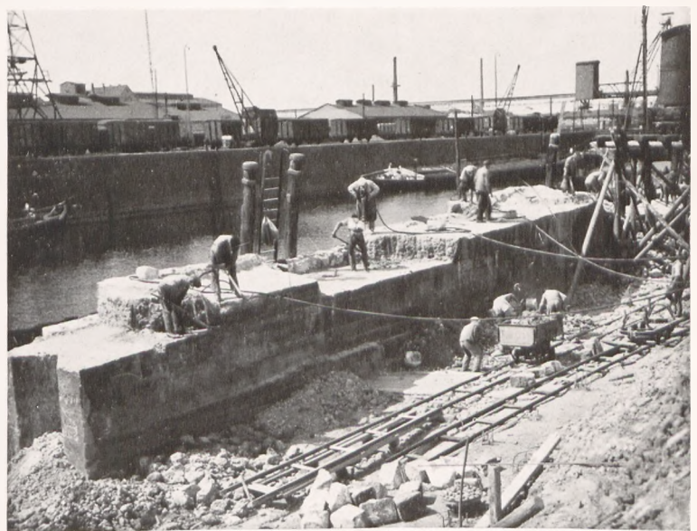
Abb. 10. Abbruch der alten Mauer.
