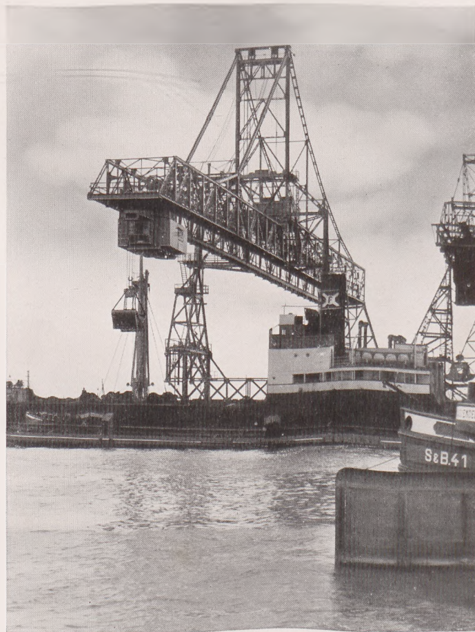
Abb. 2. M.A.N.-Verladebrücke aus St. 52 im Außenhafen von Emden. Tragkraft der Drehlaufkatze 10 t. Stützweite der Brücke 57 m, Auslegerlänge 48 m.
