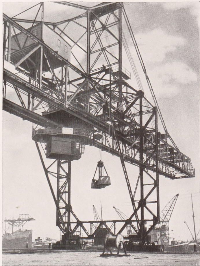
Abb. 1. M.A.N.-Verladebrücke aus St. 52 im Hafen von Rotterdam. Tragkraft der Drehlaufkatze 15 t. Stützweite der Brücke 58 m, Auslegerlänge 43 m.
