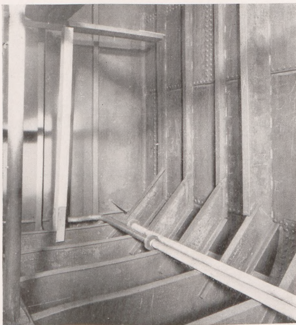
Abb. 1. Blick in einen Laderaum mit dem geschweißten Spantwerk. Vorn die Querschotte mit Versteifungswinkeln.
