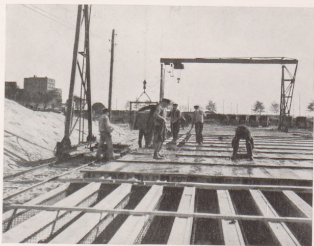
Abb. 6. Pfahlbetonierung Togokai-Süd.
