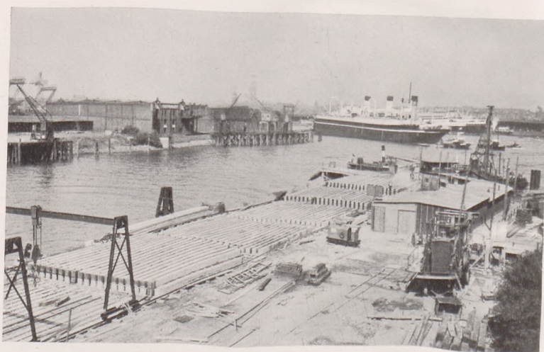
Abb. 7. Pfahlbetonierung Togokai-Nord.
