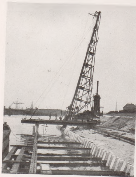
Abb. 11. Pfahlramme und Führungsholme für die Spundwand Togokai-Süd.
