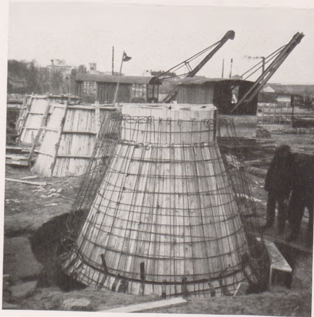
Abb. 6. Absenken eines Brunnens.
