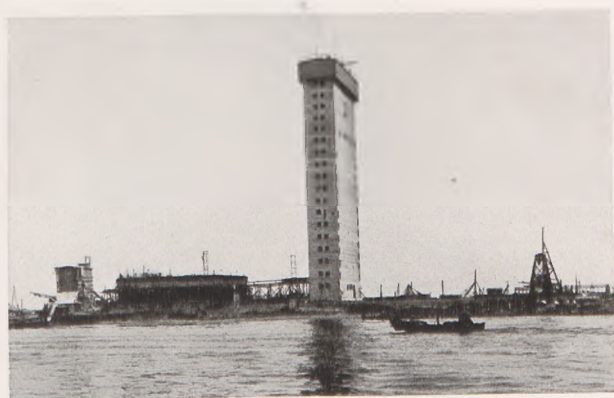
Abb. 8. Maschinenhaus, im Rohbau fertiggestellt.
