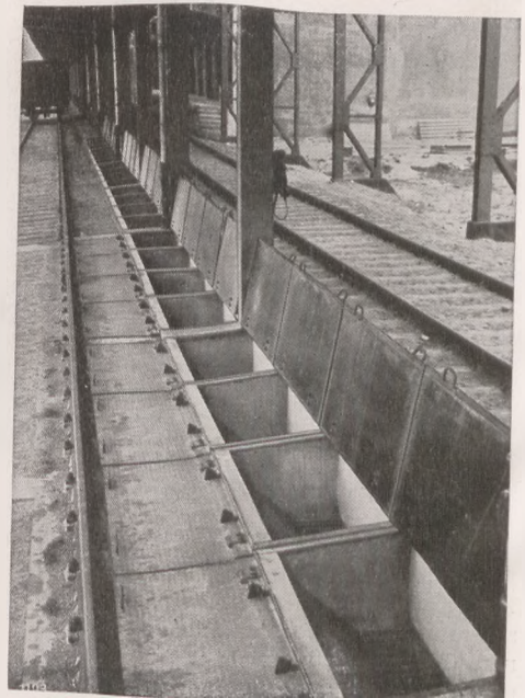
Abb. 13. Einschütttrichter auf der Wasserseite.
