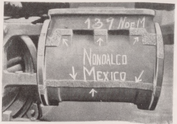
Abb. 9. Der Dampfzylinder ist wieder komplett und betriebssicher geschweißt mit Monel-Metall-Elektroden. Durch diese hier gezeigten Schweißarbeiten wurde die Eignung von Monel-Metall für die Gußeisen-Reparaturschweißung entdeckt und für die Folge in der Schwerindustrie aller Länder auch ausgeführt.
