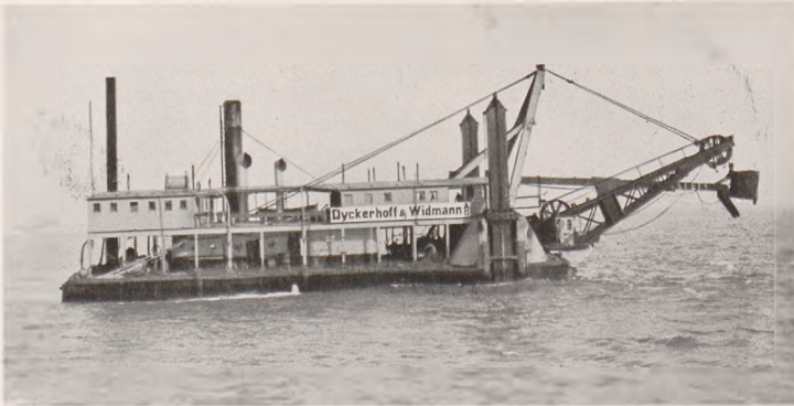
Abb. 3. Bagger „Lucayan“ vor Helgoland in Ruhestellung.
