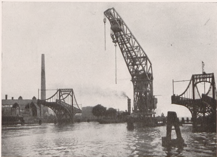
Abb. 2. Wilhelmshaven. Der 250 t-Schwimmkran durchfährt die geöffnete Kaiser Wilhelm-Brücke.
