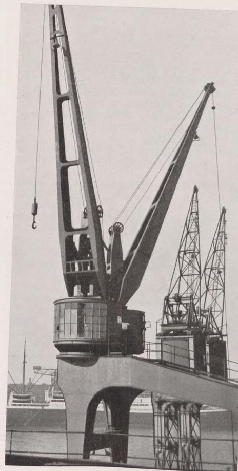
Abb. 3. Geschweißter Doppelwippkran.
