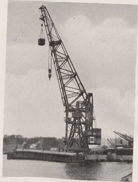
Abb. 16. 250 t-Schwimmkran Brest. Die mit 20 t belastete Laufkatze in äußerster Stellung bei ganz eingezogenem Kranausleger.
