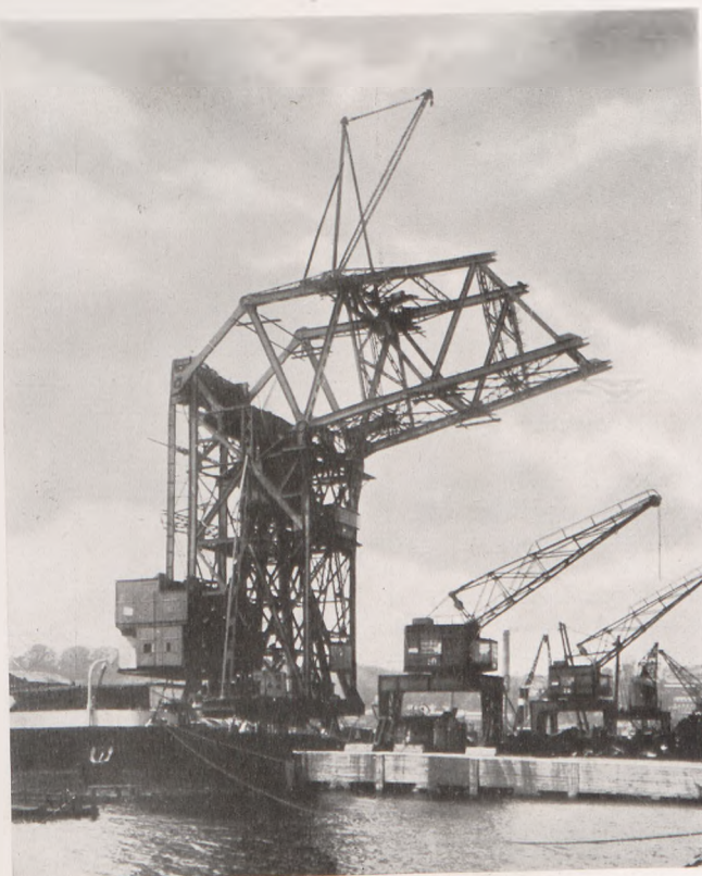
Abb. 6. DEMAG-Riesenschwimmkran im Hafen Brest. Montage des Auslegers.
