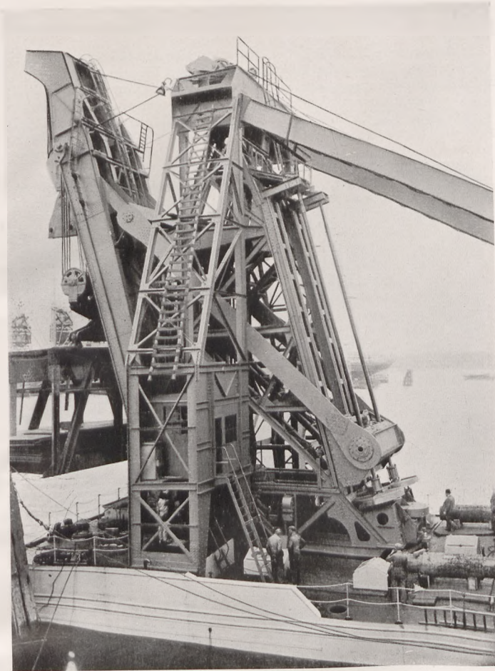
Abb. 1. 250-t-Schwimmkran für den Manchester-Schiffahrtskanal.
