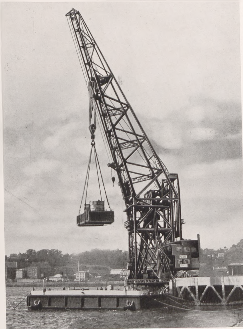
DEMAG-Riesenschwimmdrehkran im Hafen Brest mit einer 250 t-Last.
