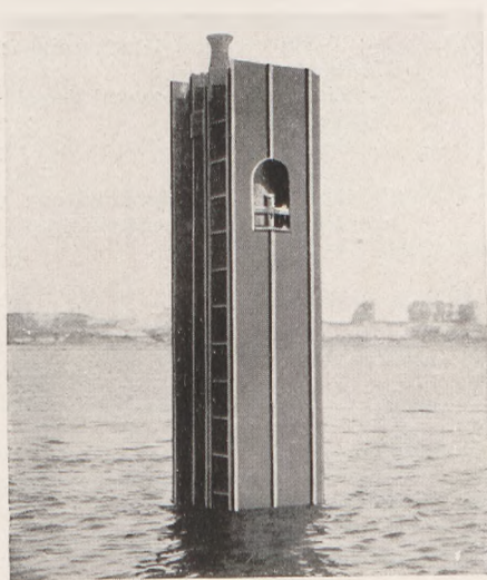
Abb. 12. Dalben aus Peiner Kastenspundbohlen PSp 40 S, 22 m lang, in einem Ostseehafen.
