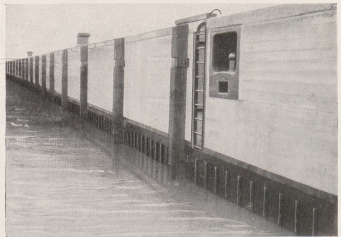
Abb. 8. Ansicht eines Teiles der fertigen Ufermauer mit Reibeholzern, Leiter, Pollern und Haltekreuz.
