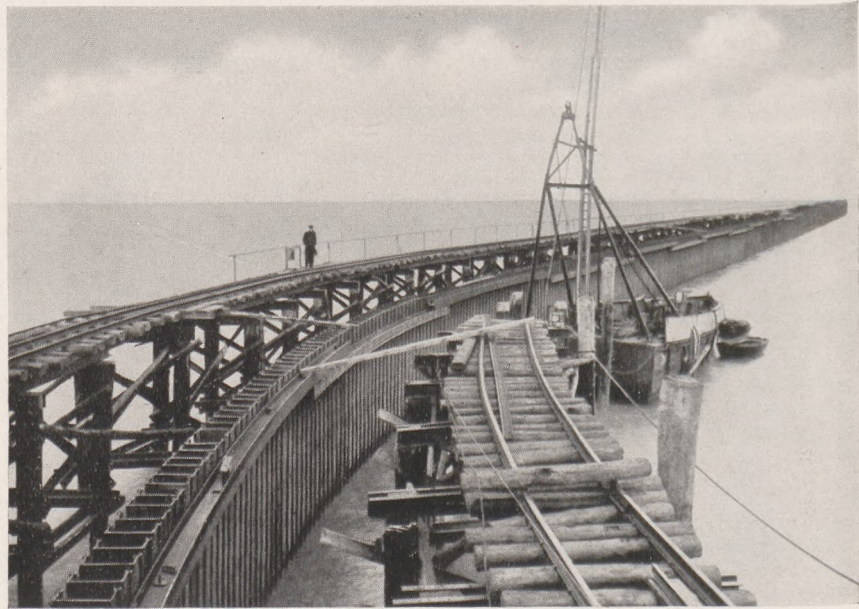
Abb. 7. Uferwand aus Peiner Kastenspundbohlen PSp 50 S an der Nordsee.
