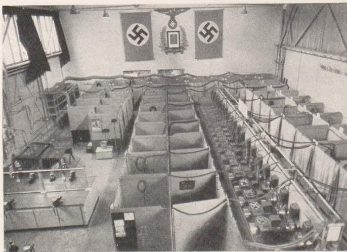
Abb. 2. Schlosser-Lehrecke. Autogen-Schneidmaschine, Schweißboxen.
