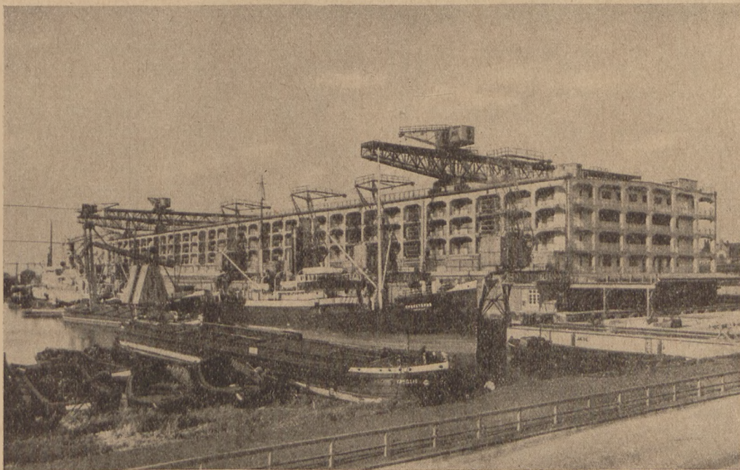
Am Freußenkai des Stettiner Freihafens steht Europas größter Schuppenpeicher. Er hat eine Länge von 210 m, eine durchschnittliche Breite von 40 m und vermag 65 000 t Güter aufzunehmen Aufn.: Stettiner Hafengesellschaft
