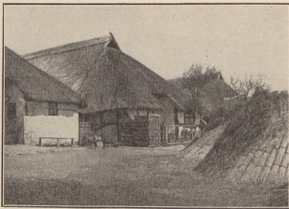
Rohrdächer und Rohrvorrat in Rapp an der Rega Aufn. Martin Reepel
