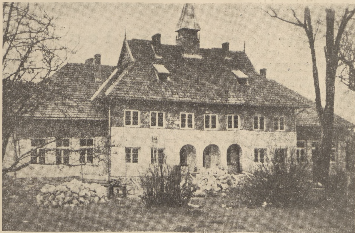
Szkoła w Stefkowej, grom. Olszanica, front od strony północnej.
