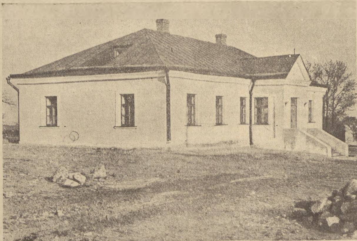
Odbudowany dom Mickiewiczów w Nowogródka.
