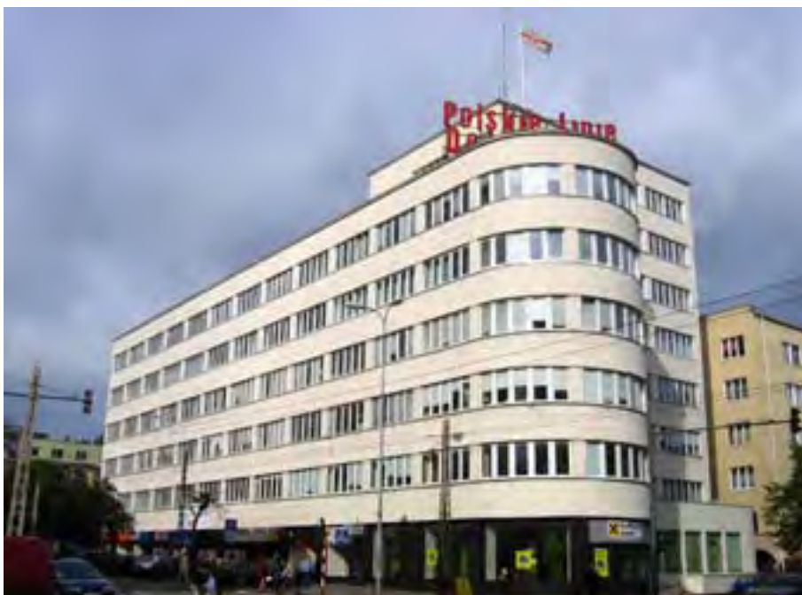
Budynek biurowy ZUS (później PLO), obecnie Urząd Miasta z lat 30. XX w., który został uznany jako pierwszy obiekt modernistyczny Gdyni za zabytek w 1972 r. Fot. R. Hirsch
