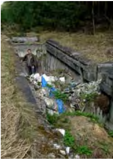
Autor w kolejowym kanale rewizyjno-naprawczym (lub wymiany wózków kołowych)
