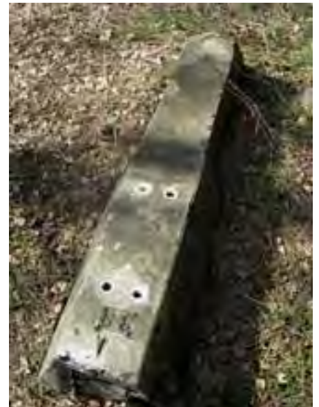
Półowa strunobetonowego pokładu kolejowego z widocznymi plastikowymi tulejkami – dowód na powojenne użytkownictwo bocznic Fot. Ł. Mejłun
