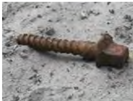
Element przytwierdzenia szyny do podkładu kolejowego Fot. Ł. Mejłun
