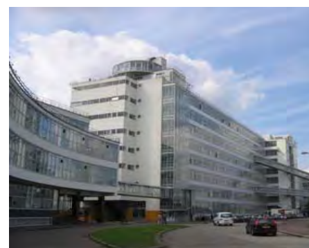
Zabytkowa już fabryka tytoniu Van Nelle w Rotterdamie (Holandia) z lat 1926-30 z imponującą wciąż przeszkloną fasadą,
