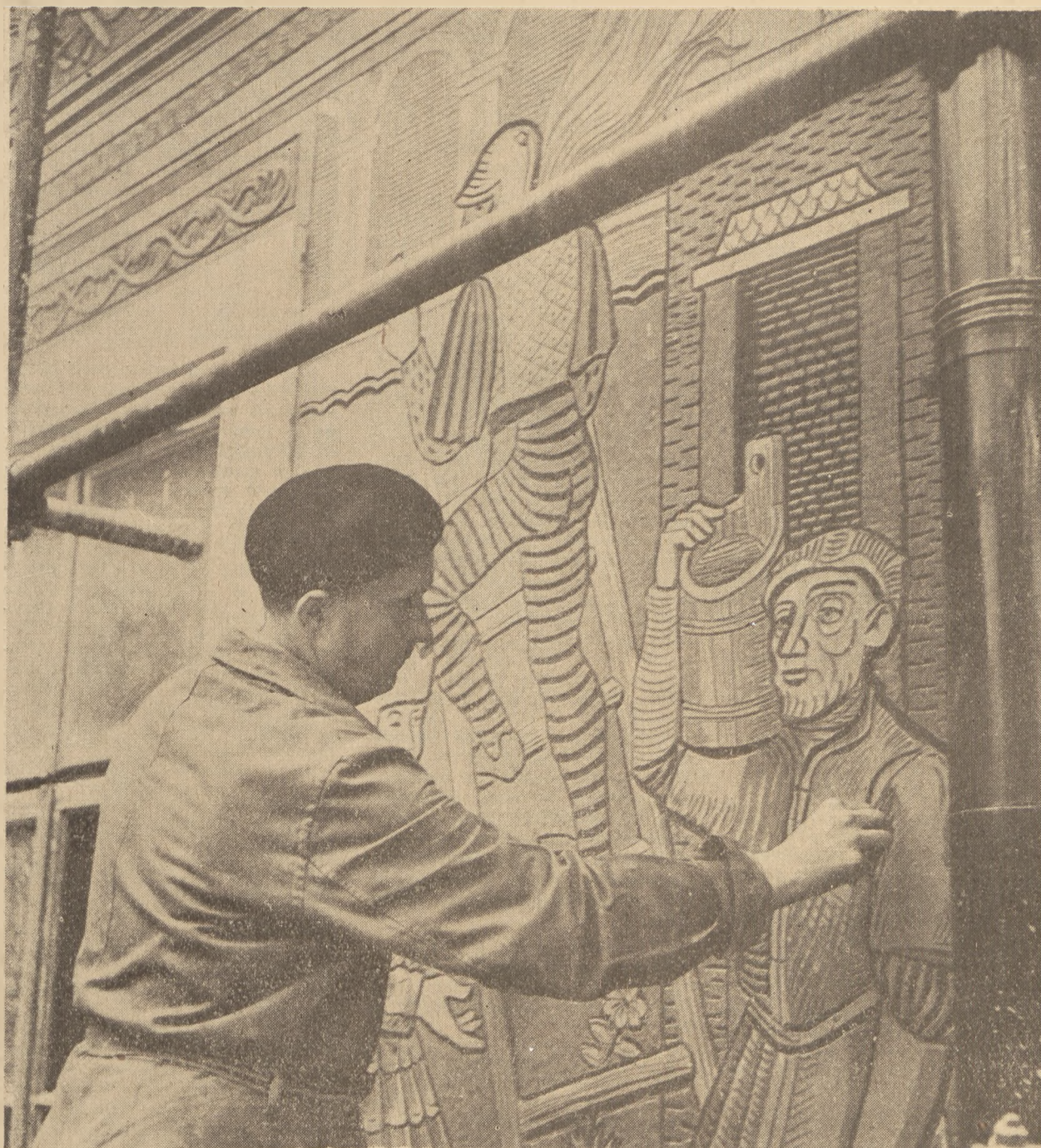
PLASTYCY PRZY REKONSTRUKCJI STAREGO MIASTA
