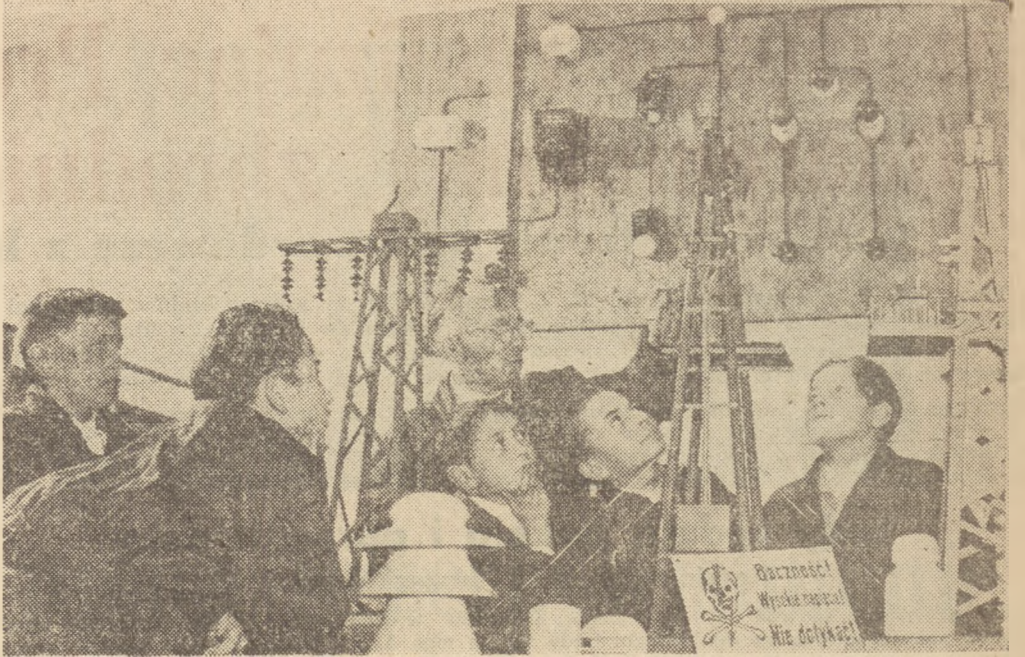
W Młodzieżowym Domu Kultury w Warszawie, w pracowni elektrotechniki instruktor węgry objaśnia chłopcom zasadę pracy podstacji wysokiego napięcia. Foto CAF
