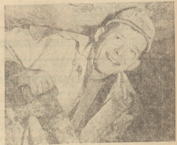
Roboty przy budowie warszawskiego metra postępują w szybkim tempie...
