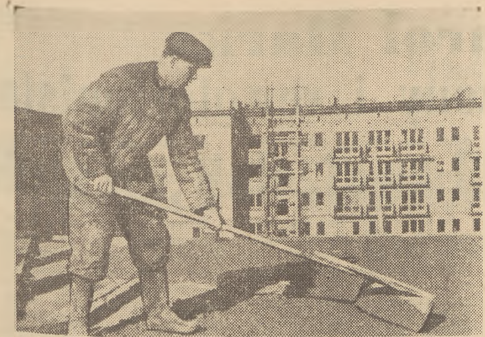
Bratwa zetempeńska Bolesława Ziarno — zdobywcy tytułu najlepszego betoniarza — pracująca przy budowie Osiedla Mieszkanlowego Miranów osiąga średnio 364 proc. normy. Foto — CAF
