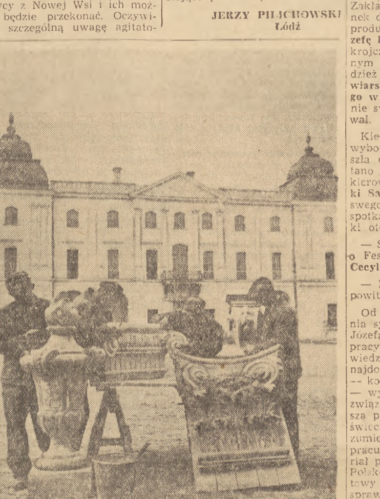
Ten pałac w Białymstoku przez długie dziesiątki lat służył magnaciej rodzinie Branickich. Władza ludowa po odbudowaniu ze zniszczeń wojennych oddała go w użytkowanie szetek młodzieli jako pomieszczenie Akademii Lełorskiej. Na zdjęciu: ostatnie prace szkieletowe. Brygada Antoniego Wasilewskiego wykonywa stylowe szkatułki.
