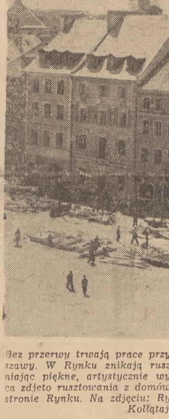
Bez przerwy trwają prace przy odbudowie Traktu Starej Warszawy. W Rynku znikają rusztowania z kamieniczek odbudowanych pięknie, artystycznie wykonane elewacje. W dniu 9 czerwca zdjęto rusztowania z domów po zachodniej kolumnańskiej stronie Rynku. Na zdjęciu: Rynek Starego Miasta — strona Kolumna.
