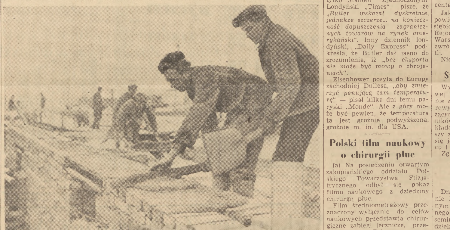
Mimo niesprzyjających warunków atmosferycznych, obfitych opadów śnieżnych i parostopionego mrozu, na warszawskich budowach nie ustają roboty murarskie... Na warszawskich budowach
