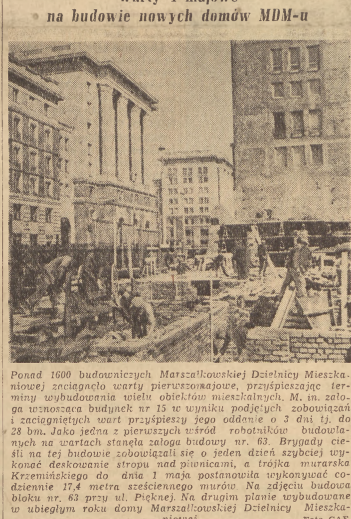
Ponad 1600 budowniczych Marszałkowskiej Dzielnicy Mieszkalniowej zaciągnięli warty pierwszomajowe, przyspieszając terminy wybudowania wielu obiektów mieszkaniowych. M. m. załoga wnosząca budynek nr 15 w wyniku podjętych zobowiązań i zaciągniętych wart przyspieszyła jego oddanie o 3 dni tj. do 28 bm. Jako jedna z pierwszych wśród robotników budowlanych na warchach stanęła załoga budowy nr. 63. Brygada cieniła na tej budowie zobowiązała się o jeden dzień szybciej wykonać deskowanie stropu nad piwnicami, a trójka murarska Krzemieńskiego do dnia 1 maja postanowiła wykonać codziennie 17,4 metra sześciennego muru. Na zdjęciu budowa bloku nr. 63 przy ul. Pięknej. Na drugim planie wybudowane w ubiegłym roku domy Marszałkowskiej Dzielnicy Mieszkalniowej. Foto CAF
