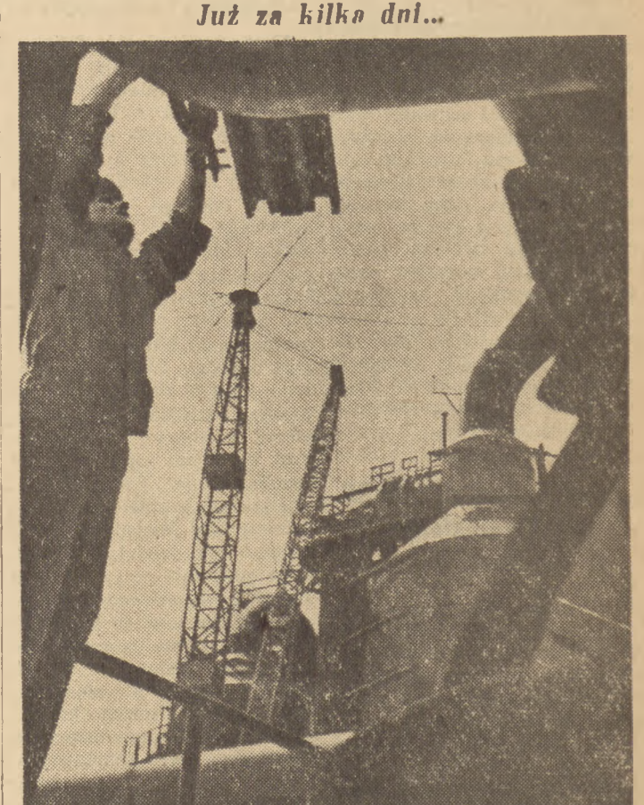
Na budowie huty im. Bolesława Bieruta w Częstochowie trwa już ostatnie prace nad uruchomieniem wielkiego pieca. Na zdjęciu: ślusarz Czesław Gluzak przeprowadza kontrolę urządzeń. Foto A. Nowodelski
