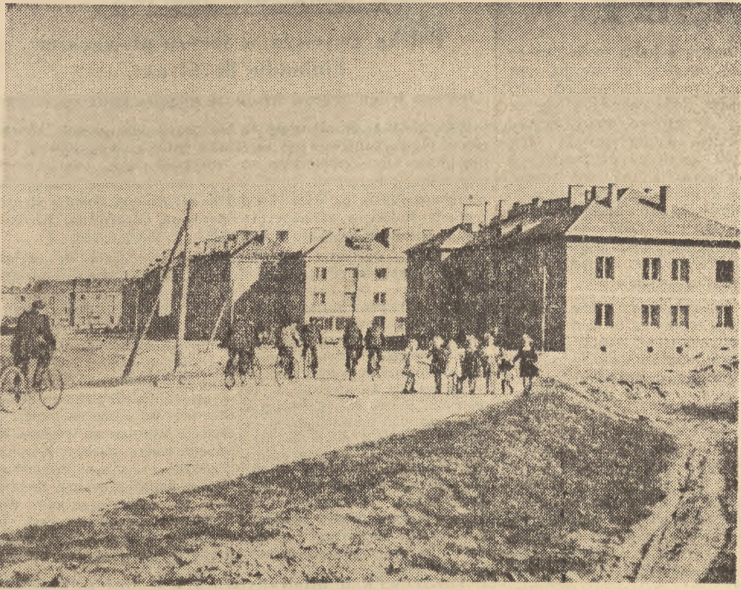
Śląsk jest obecnie największym ośrodkiem budownictwa mieszkaniowego w Polsce. W hr. ZOR prowadzi tu budowę 21 tys. izb mieszkalnych. Na zdjęciu: fragment nowego osiedla mieszkaniowego Boguszczyce. Foto A. Nowosiński
