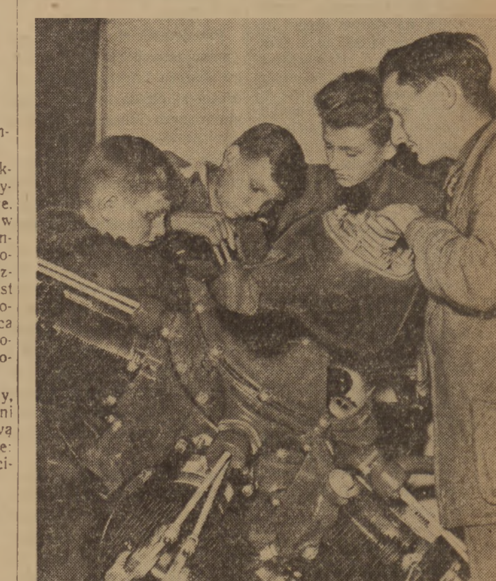
Palac Młodzieży im. Bolesława Bieruta w Stalingradzie otrzymał ostatnio od wojska wiele cennych podarków. I tak dzięki otrzymanemu przekrojeni silnika lotniczego — chłopcy z pracowni modelarskiej Palacu szybciej i lepiej poznają zasady działania silnika lotniczego. Na zdjęciu: instruktor Jan Tomaszewski objaśnia młodzieży działanie i budowę silnika samolotu sportowego. Foto A. Nowostelski
