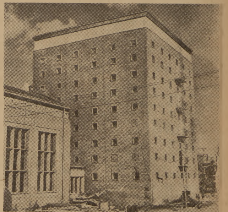
W Klemensowie w pow. zamojskim powstaje nowoczesny kombinat tłuszczowy, który będzie największym i najnowocześniejszym obiektem tego typu w Polsce. Pierwsze działy kombinatu zostaną uruchomione już w roku przyszłym. Wraz z fabryką powstaje nowoczesne osiedle mieszkalne, w którym znajdzie się również ambulatorium lekarskie, apteka, kino, żłobek i przedszkole. Na zdjęciu: budowa działu ekstrakcji. Foto CAF — Tymitński
