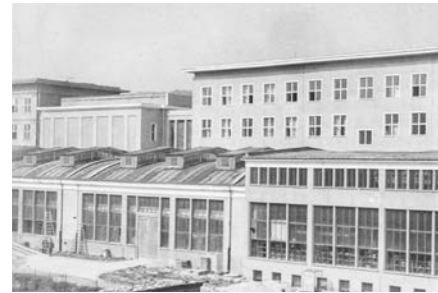
1, 2 fot. / photo: Kazimierz Lelewicz I Zbiory Sekcji Historycznej Biblioteki Politechniki Gdańskiej / Archives of the Historical Section of the Library of the Gdańsk University of Technology 3 fot. / photo: Witold Węgrzyn
