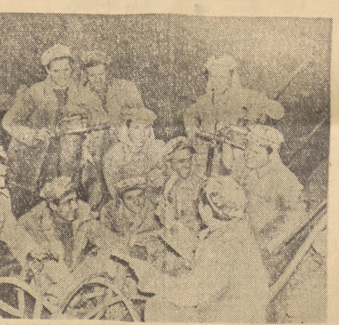
Obecnie w Bułgarii w budowie jest wielka elektrownia wodna „Batak”, na której poważnie osiągnięcia produkcyjne ma młodzież. Na zdjęciu: narada robocza młodzieżowej brgady Pawła Iwanowa. Foto — CA7
